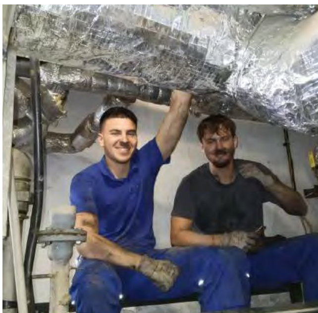
Wenig Platz, viel Einsatz: #1AINSTALLATEUR Paco aus Wien-Hütteldorf zeigt Baustellenalltag dort, wo andere gar nicht erst hinkommen.
