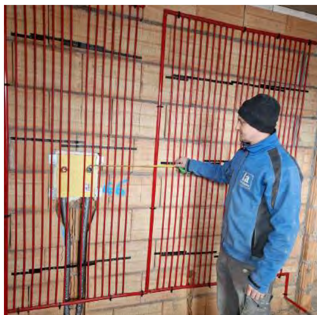
Florian vom #1AINSTALLATEUR Tschernuth in Gallneukirchen nimmt nach der Montage der Wandheizung noch die Maße, damit alles passt.
