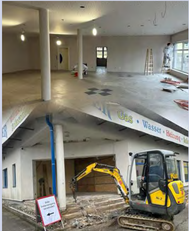
Neues Büro, neue Fassade und moderne Technik – bei Hauer wird gerade kräftig modernisiert. Fotos: Hauer
