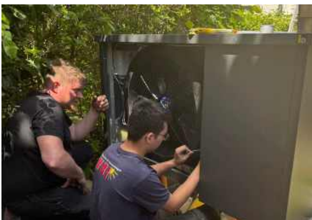
Obermonteur Hr. Renk schult Lehrling Noah vom #1AINSTALLATEUR Weissinger gerade in die korrekte Montage einer Wärmepumpe ein.
