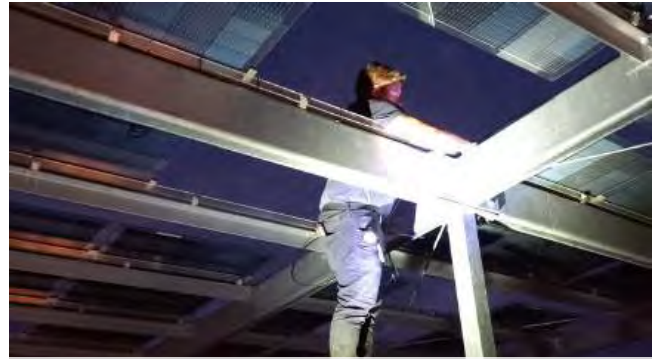
Eine Baustelle über den Dächern Wiens wurde von #1aINSTALLATEUR Weissinger aus Friedersbach nach einem nächtlichen Einsatz fertiggestellt.
